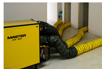
Varmen ledes ind vha. varmeslange
