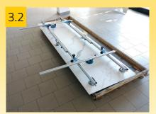
Placer flisen på den lange led, på siden af trækassen, og monter rammen
