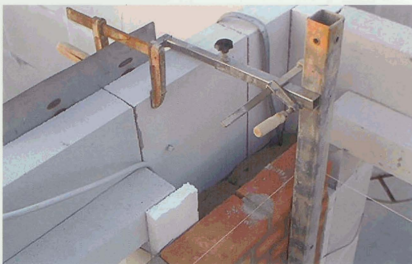
- Indvendig hjørne med vægkonsol.
