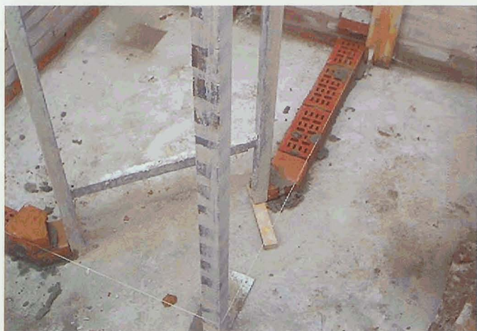
Her er et eksempel på opstilling til bruseniche med 45° hjørne og bue.
